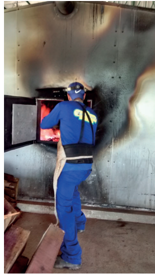
Imagem 03 Trabalhador sem EPIs adequados na Empresa C. (fonte: próprio autor)
