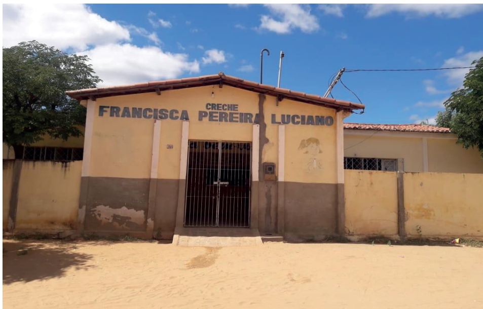
Figura 1 – Fachada da Creche Municipal Francisca Pereira Luciano, município de Parelhas/RN.
