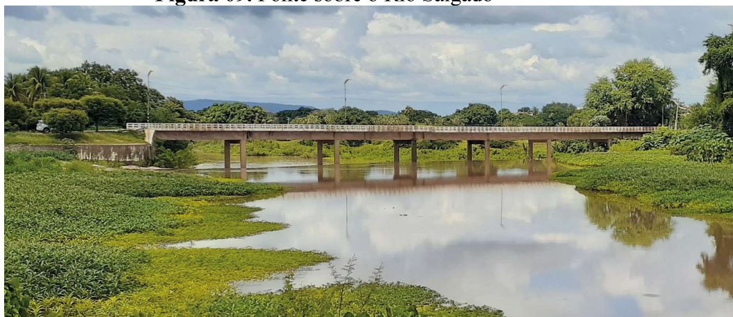
Figura 09. Ponte sobre o Rio Salgado
