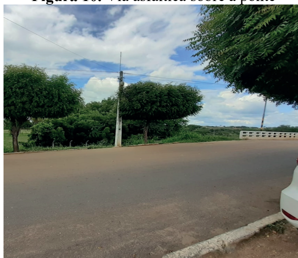
Figura 10. Via asfáltica sobre a ponte
