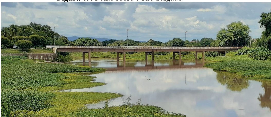
Figura 09. Ponte sobre o Rio Salgado
