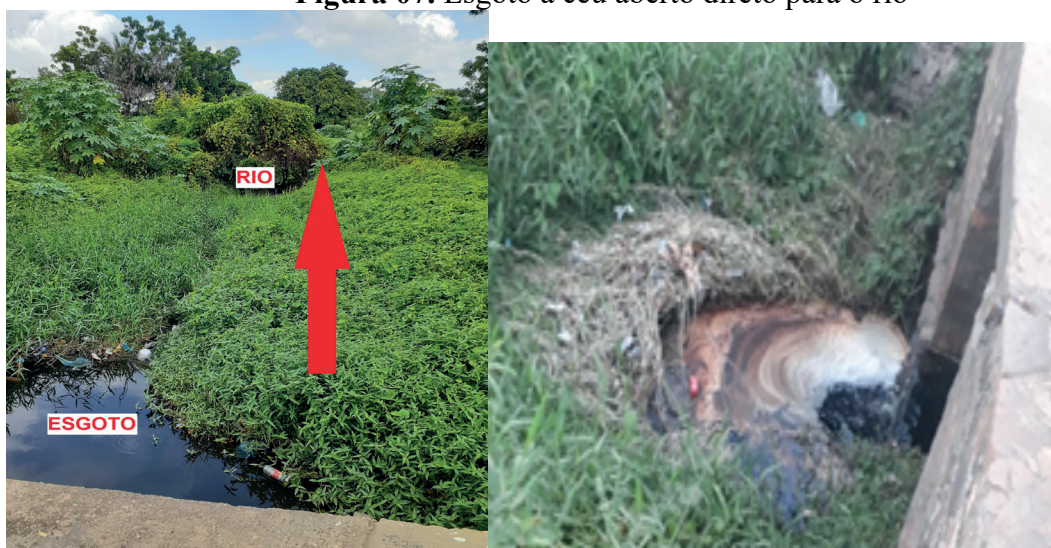
Figura 07. Esgoto a céu aberto direto para o rio
