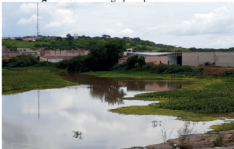
Figura 05. Casas e galpões próximos ao rio
